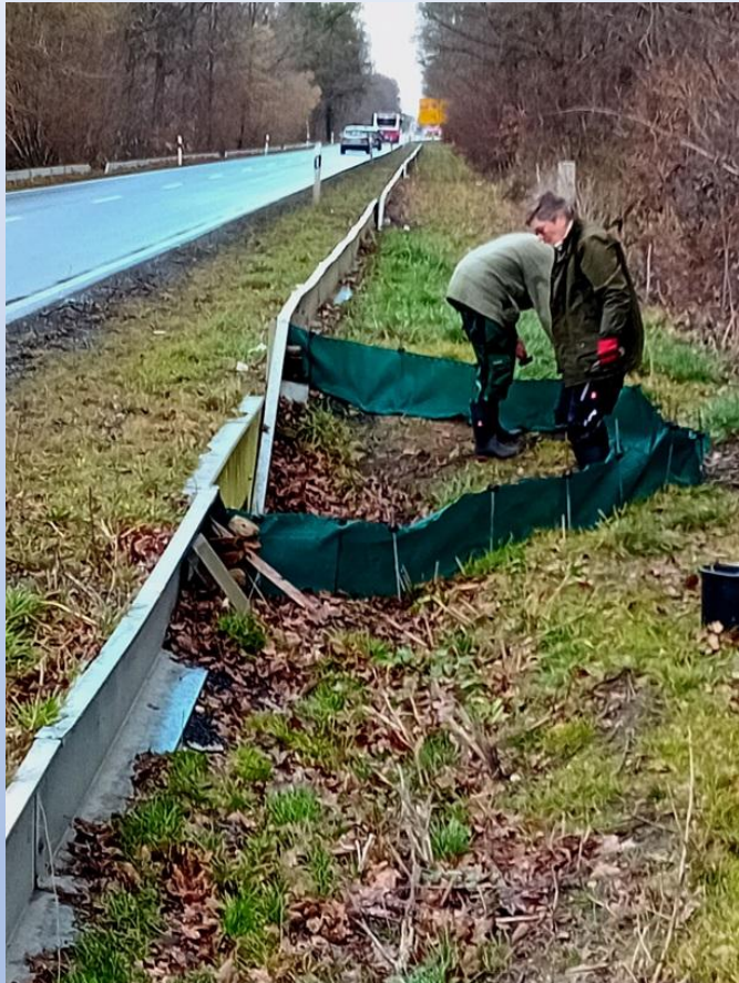
An einem Tunnel haben wir den Abfangzaun aufgebaut
